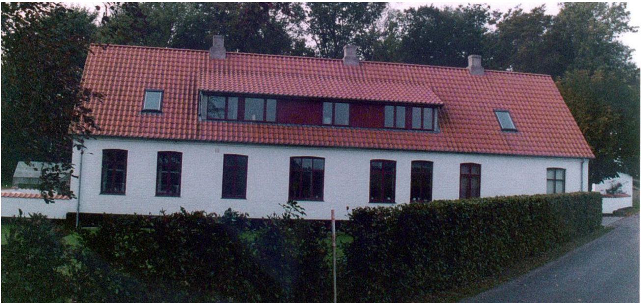
Den gamle skole efter at den blev omdannet til bolig. Foto fra 2009.
