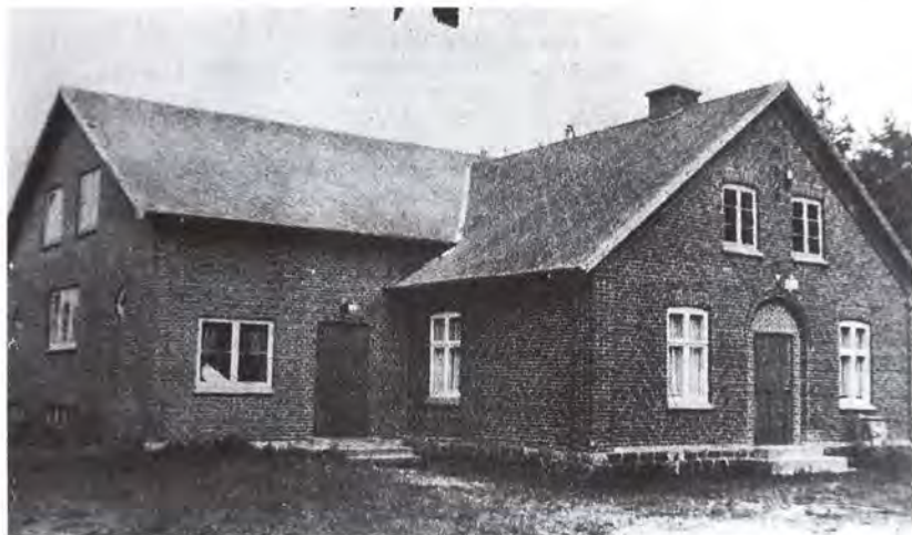
Langkastrup Forsamlingshus som det kom til at se ud efter ombygning.
