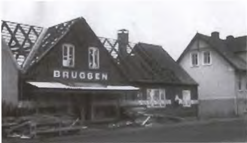
Nedrivningen af den oprindelige brugs i 1967.
