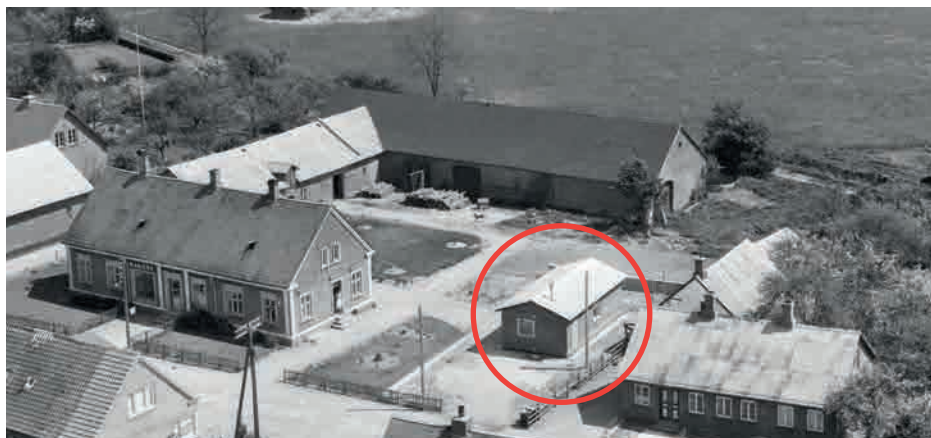
Det nye frysehuse bygget i 1951. Luftfoto fra 1955. Foto: Sylvest Jensen Luftfoto; Det Kgl. Bibliotek.
