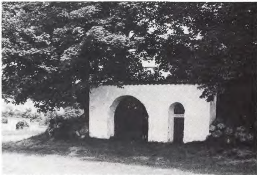
Den senmiddelalderlige kirkegårdsportal til den gamle Essenbæk kirkegård er placeret i sydvesthjørnet af det helt ubrudte kampestensdige. Bygget af munkesten som menighedsrådet hvert år lader kalke hvide. Teglhængt med vingetegl af ny type. Nye trælåger, dog kan en svær portramme af træ være meget gammel. Den nye efterligning i baggrunden hører til Essenbæk hører til Essenbækgård. Foto: Kirsten Nijkamp, KHM 1983.
