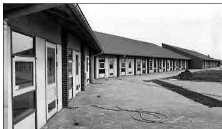
I 1978 blev Assentofthjemmet opført og i 1979 holdt man rejsegilde på Møllehjemmet i Auning.
