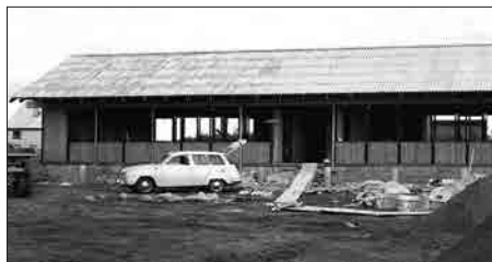
I 1973 blev der oprettet børnehaveklasser i både Assentoft og Auning. Her ses byggeriet af lokalerne til børnehaveklasserne ved Assentoft Skole.
