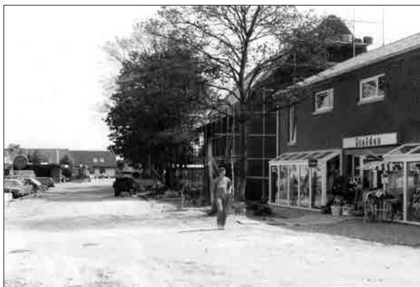
Byggeriet på Centervej i fuld gang.
