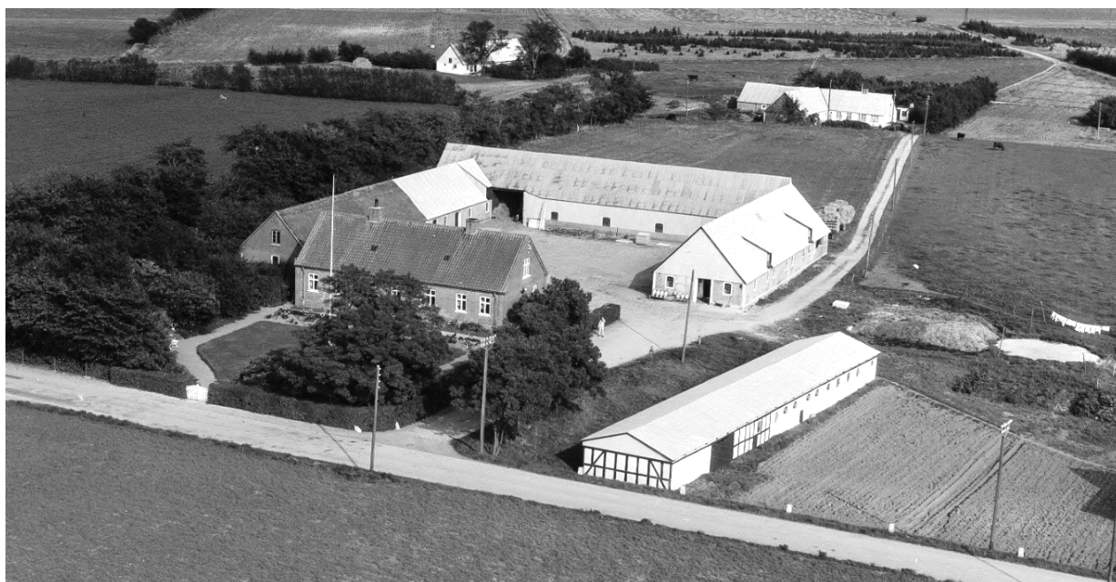
Drammelstrupgård, Drammelstrupvej 8. Foto fra 1961.
